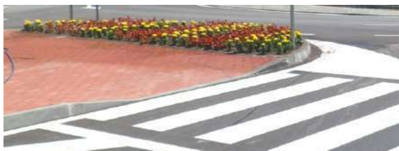
Detalj rampe od betonske galanterije
