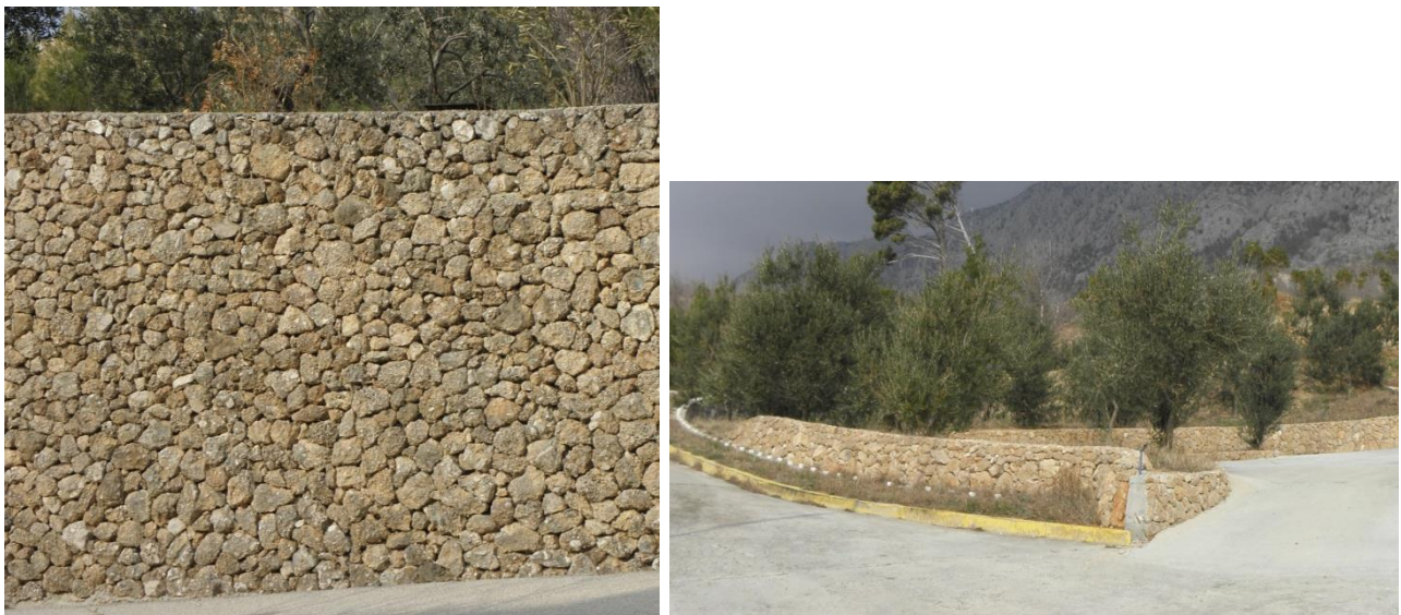
Slika 5. Primjeri potpornog zida obloženog deluvijalnim brečama
